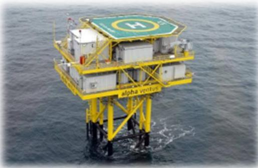
En los casos en los que se hace necesaria la instalación de Subestaciones Offshore, esta aumenta el voltaje de la electricidad generada antes de su transmisión a tierra firme, para reducir las pérdidas eléctricas. La subestación está instalada en una estructura de soporte y contiene instalaciones para permitir el acceso marítimo y aéreo en la mayoría de los casos,
