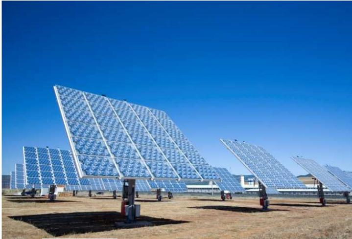
Se dispone de un elemento óptico que concentra la luz sobre la célula. Son necesarios dispositivos de seguimiento muy precisos (error de  $0,4^\circ$ ) porque solo se aprovecha la radiación solar directa
