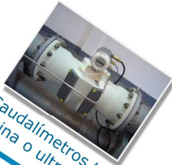
Caudalímetros tipo turbina o ultrasónicos
